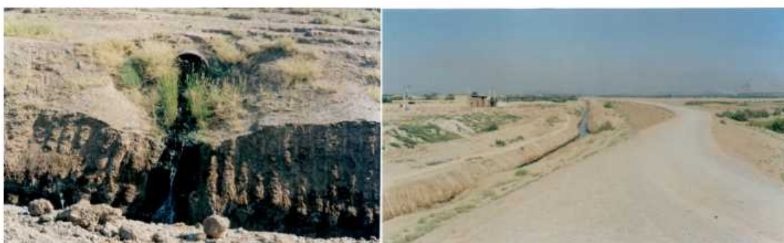
شکل ۳. نمایی از زهکش استخرهای تیخیری (ذخیره پساب) (سمت راست) و نمایی از خروجی پساب از استخرهای تیخیری و ورود به زهکش (سمت چپ)
