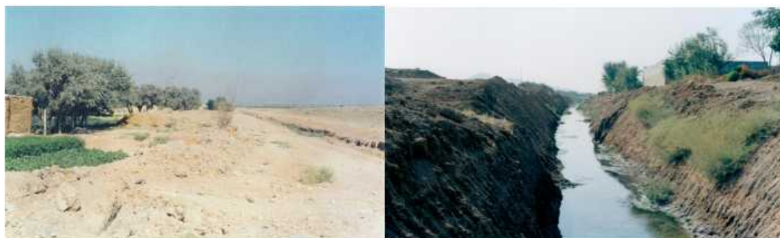
شکل ۴. نمایی از زهکش استخرهای تیخیری (ذخیره پساب) واحد صنعتی ذوب آهن اصفهان (سمت راست زهکش به همراه ساختمان پمپاژ پساب برای اراضی کشاورزی و سمت چپ زهکش را در مجاورت مزارع نشان می دهد)
